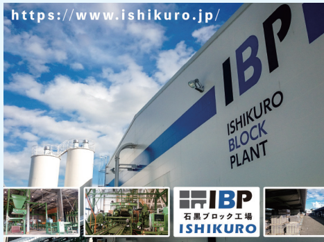
富山県小矢部市にある自社ブロック工場
